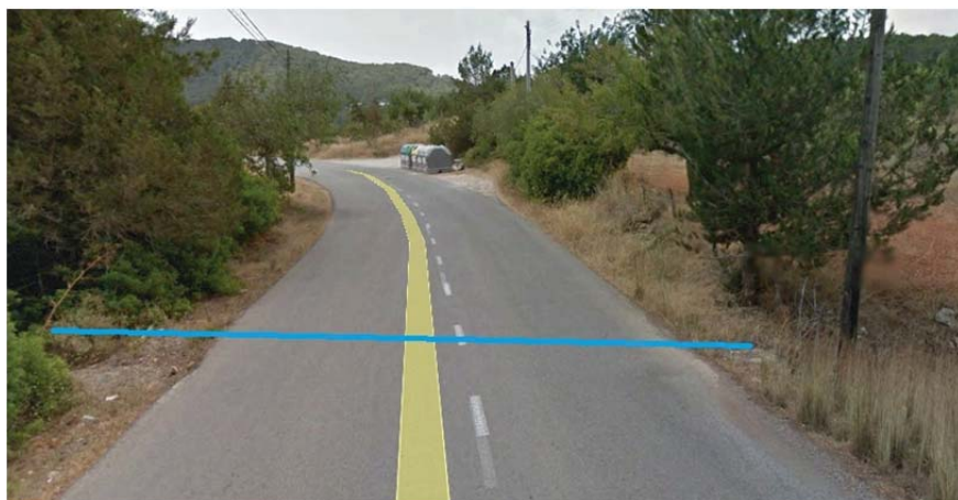
Imagen 26. Cruce Torrente, Tramo 7. PK. 4+210.
