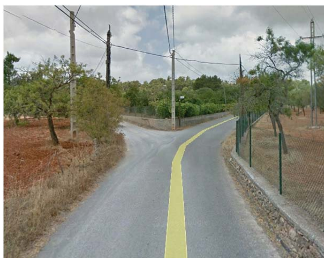
Imagen 11. Curva hacia derecha. Tramo 6. PK. 1+000.
