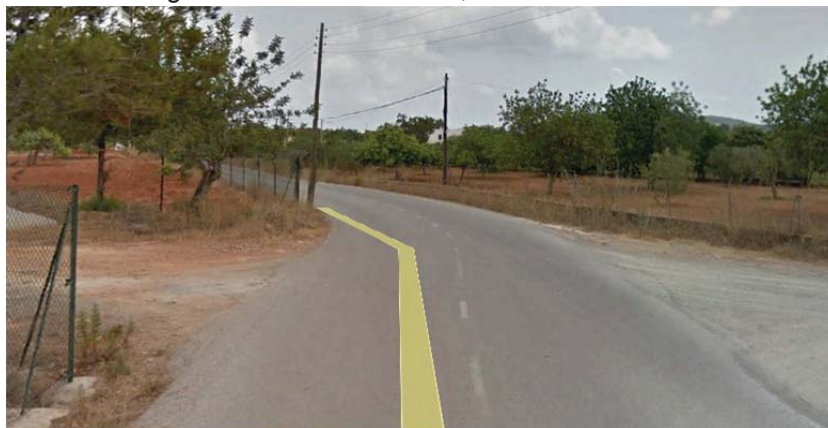
Imagen 23. Cruce curva a izquierda, Tramo 7. PK. 3+660.
