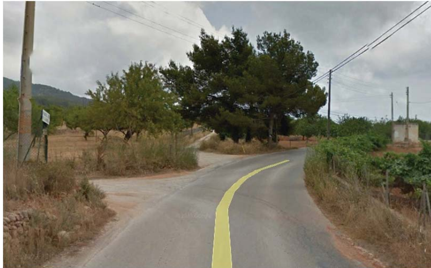
Imagen 24. Curva a derecha, Tramo 7. PK. 3+800.
