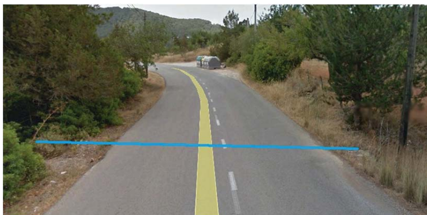
Imagen-Cruzamiento con torrente en Tramo 7.
