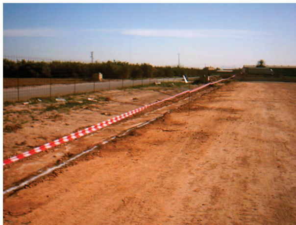
Modo de balizar los pozos de zapatas y zanjas de correas
