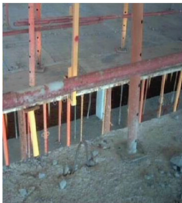
-Sargentas colocadas antes del armado del forjado. Las barandas tienen que llevar pasamanos, elemento intermedio y rodapiés de 15 cm.
