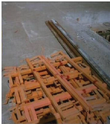
-Sargentas, necesarias para proteger bordes de encofrado.
