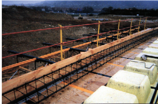
-Ejecución de forjado protegido mediante barandas
