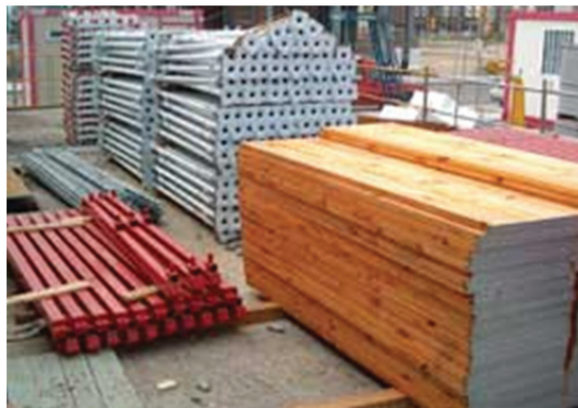
-Modo de acopiar el material de encofrado. Realice el estrobo de las cargas de modo doble; de modo que el ángulo formado por las dos eslingas sea inferior a 90°
